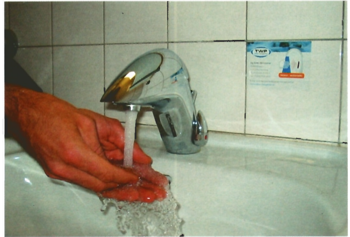
Moderne Armaturen und Sensortechnik leisten einen wichtigen Beitrag zu effizientem Wassereinsatz in öffentlichen Gebäuden.
